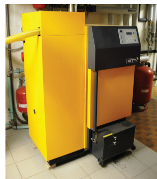
Caldaia ETA modello PE-K 50
